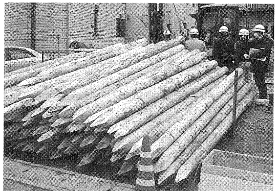
長さ4.5mの間伐材の丸太が積まれた施工現場
