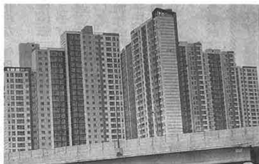
ベランダの利用方法が外観にも大きく影響する
