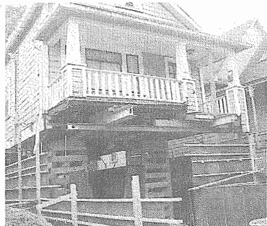
米国・ポートランドにおける木造住宅改修の一例
